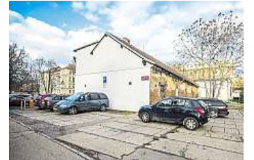
Konírna pro autobusy K historickým budovám kampusu patří bývalá budova koníren, která byla necitlivě přestavěna na garáže pro autobusy. Foto: Tomáš Krist, MAFRA
