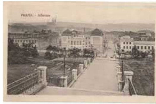
Původní stav schodiště - zábradlí, osvětlení (VO), zádlažba
